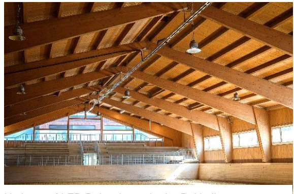
Umbau auf LED-Beleuchtung in der Reithalle; © Thomas Suchanek / Vetmeduni
