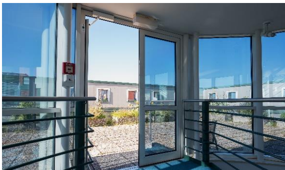
Folierung der Verglasung zur Verringerung der Sonneneinstrahlung; © Thomas Suchanek / Vetmeduni
