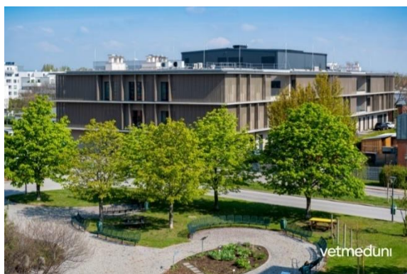
Neubau der Kleintierklinik, © Michael Bernkopf / Vetmeduni
