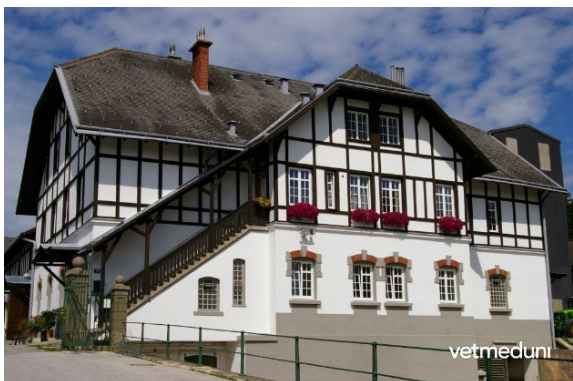
Abbildung 5: Kremesberg; Hauptgebäude der VetFarm © Manfred Kiesling / Vetmeduni
