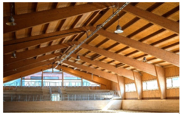
Abbildung 14: Umbau auf LED-Beleuchtung in der Reithalle © Thomas Suchanek / Vetmeduni
